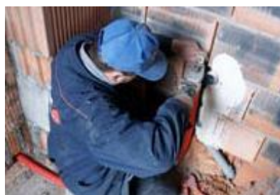
Monter sieci, instalacji i urządzeń sanitarnych
