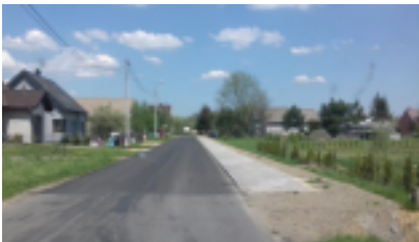
Rozbudowa DP 3210S i DP 3207S ulica Główna w Zendku.
