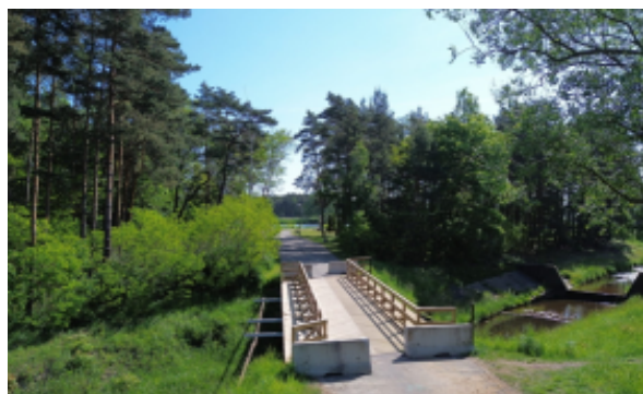
Remont Mostu w Zielonej.
