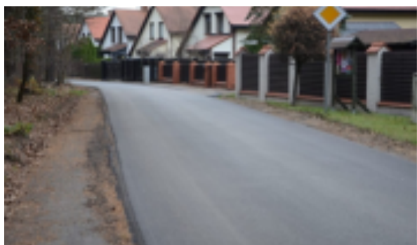
Modernizacja drogi powiatowej nr 2352S ul. Kaletańska w Boruszowicach.
