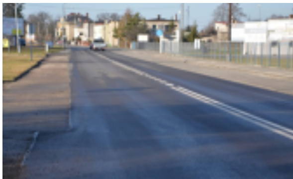
Modernizacja drogi powiatowej nr 3248S ul. Fabrycznej.
