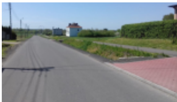
Budowa ścieżki rowerowej na odcinku Laryszów - Miedary.
