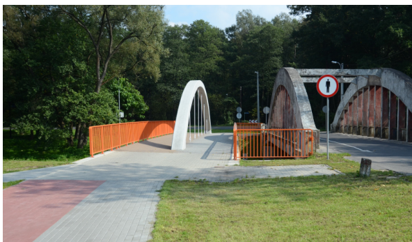
Przebudowa mostu drogowego w ciągu DP 3222S ulica Mickiewicza.
