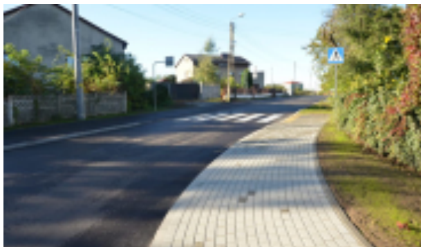
Rozbudowa DP 3200S na odcinku od DK 78 do ulicy Mickiewicza w miejscowości Ossy.
