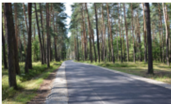
Modernizacja nawierzchni jezdni wraz z odbudową podbudowy oraz poboczy drogi powiatowej nr 3248S ul. Kaletańskiej w Mikolesce.
