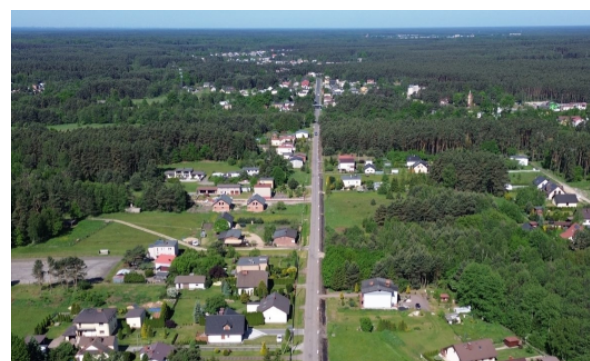
Przebudowa DP 2335 S ul. Ofiar Katynia - zadanie w trakcie realizacji.
